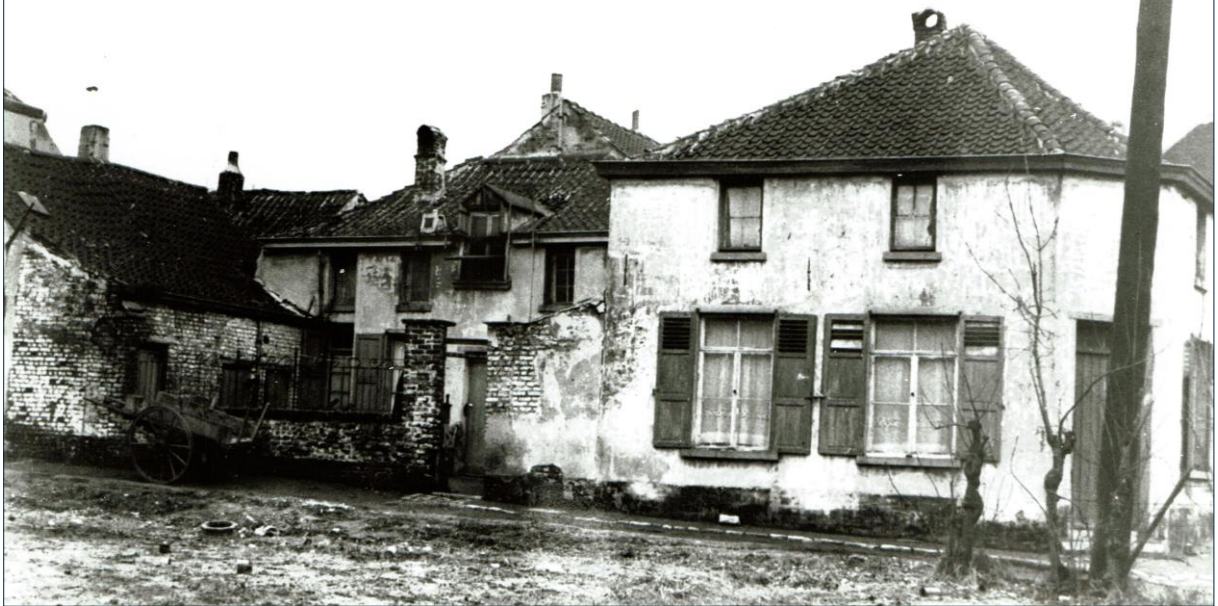
Aanleg van de J. Loossensstraat, gezien vanuit (geplaveide) Augustijnnonnenstraat, ca. 1955 Aménagement de la rue J. Loossens, vu depuis la rue des Augustines (déjà pavée), vers 1955
